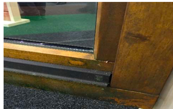
Aucune dégradation visible du revêtement
